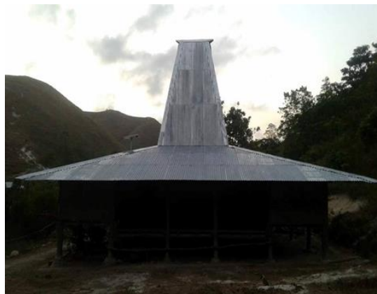
Gambar : Tampak Rumah Adat Tipologi 2
