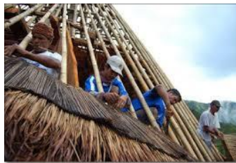
Gambar 11 : Proses pengatapan Mbaru Niang
