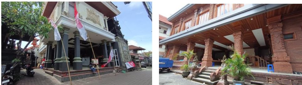
Gambar 1. Bale Banjar yang mengalami perubahan tipologi ruang (terbuka-tertutup), zona horizontal menjadi vertikal.
